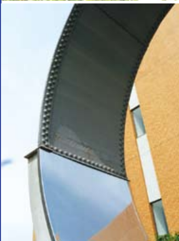
(中上)千住キャンパスになる前は小学校でした。その記念碑も隣に並んでいます。 (中下)無数に打たれたリベットが、80年間もの過去の先端技術を物語ってくれます。
