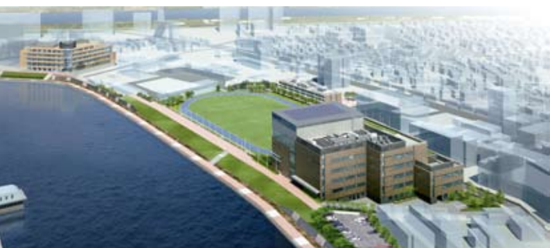
■ 太陽光発電 体育館の屋根部分には、屋根材と一体型の太陽光発電モジュール（50KW）が組み込まれています。
