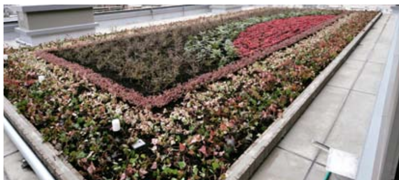
■ 屋上緑化 緑化によって屋根面への日射に対する断熱性能を向上させています。
